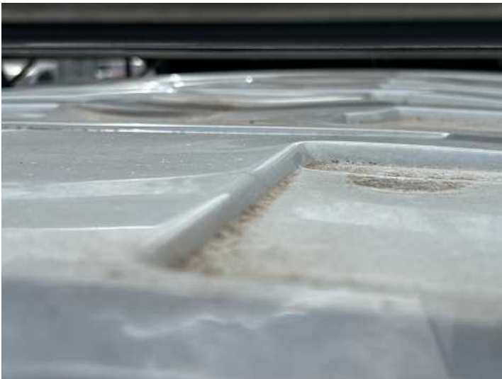
Dach (Verformung)
