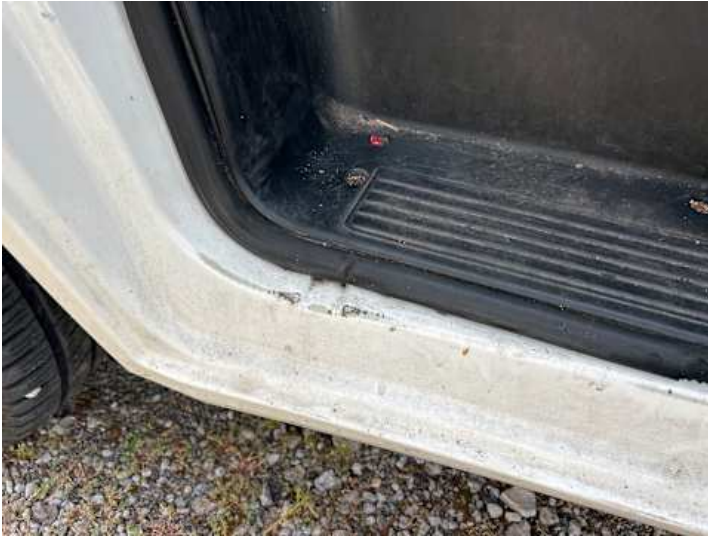
Schweller links (Kratzer)
