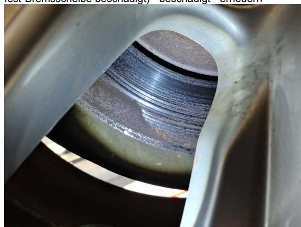
Beschädigung 7: Bremsanlage: Bremsanlage (Bremsattel fest-Bremsscheibe beschädigt) - beschädigt - erneuern
