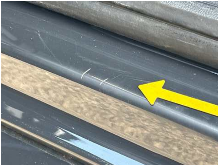
Schweller links (Kratzer)
