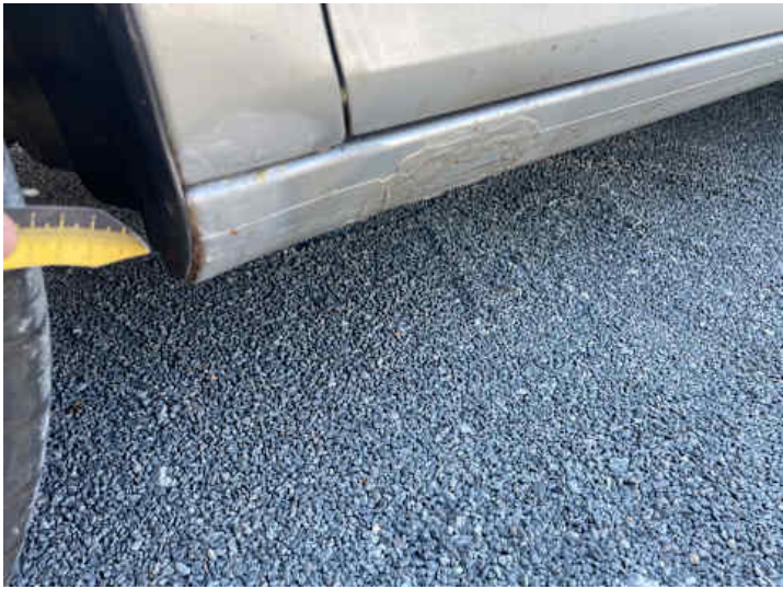
Schweller links (Rost)
