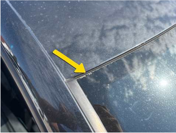
Windschutzscheibe (Anderer Schaden): Ablösung
