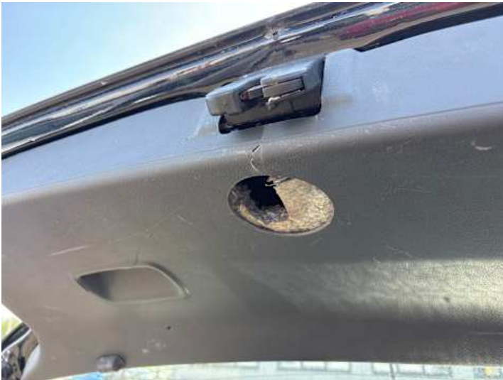
Innenraum (Verschleiß, Riss/Bruch)
