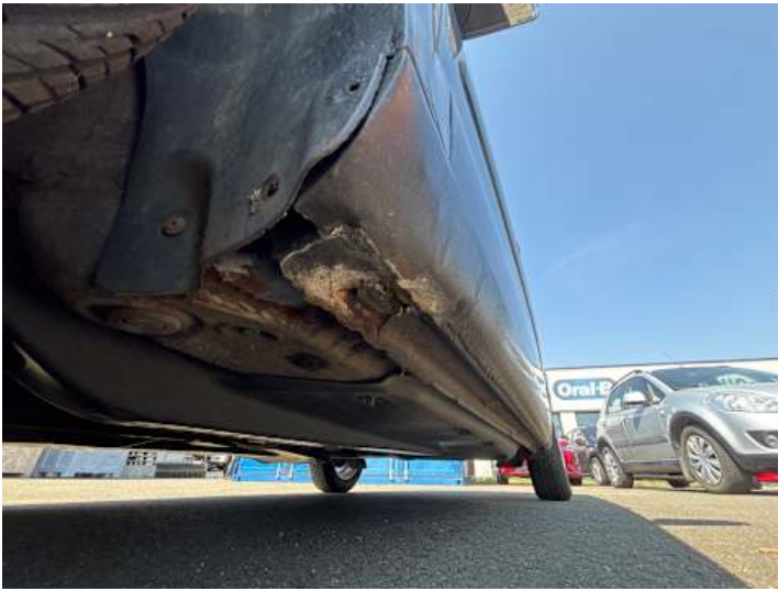
Schweller links (Unsachgemäß instand gesetzt, Rost)
