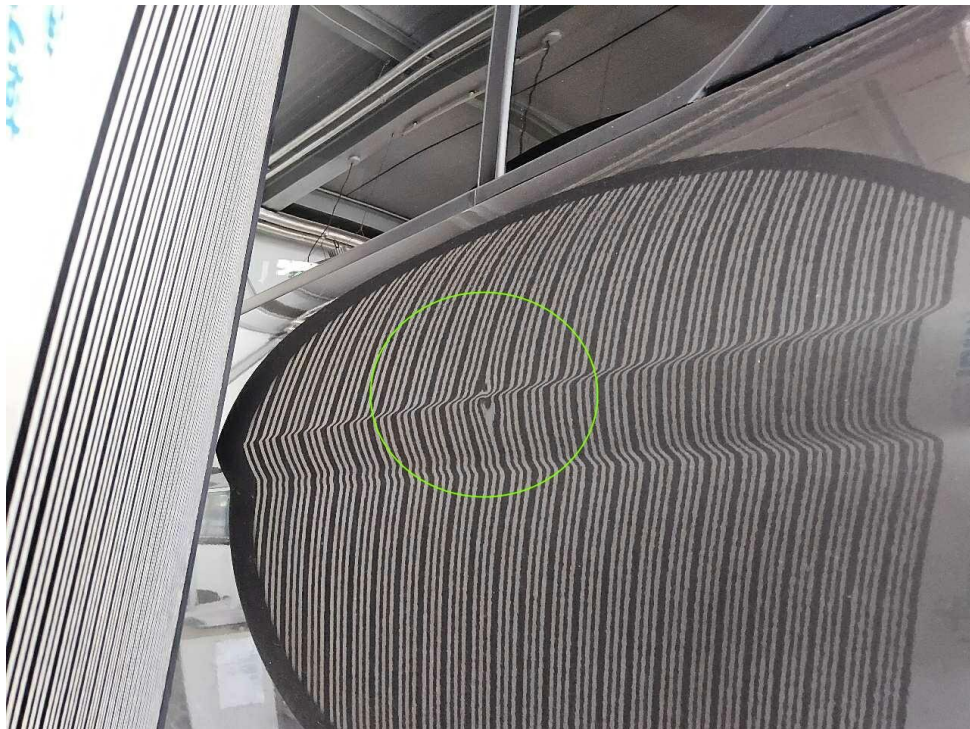
Bild 24 : Schiebetür links mehrfach eingedellt
