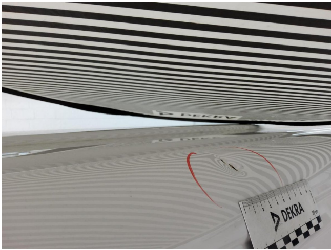
Dachrahmen hinten rechts außen, deformiert, instandsetzen und lackieren mit Lackaufbau (DEKRA)
