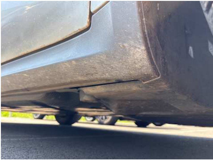
Schweller rechts (Rost)
