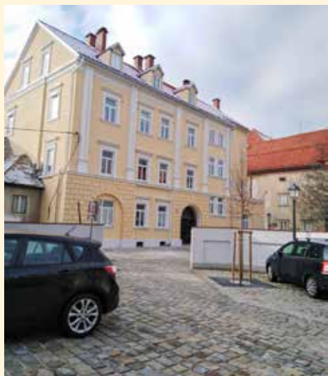
Današnje obnovljeno stanje hiše.
