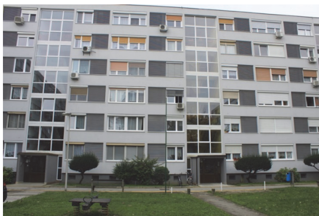
Obnovljena fasada na bloku Trubarjeva ul. 46, 48, 50, foto: Riko Mlekuž
