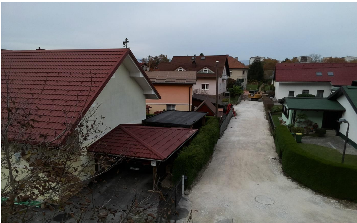
Obnova Grudnove ulice (obnova vodovoda, kanalizacije in ceste), foto: Riko Mlekuž
