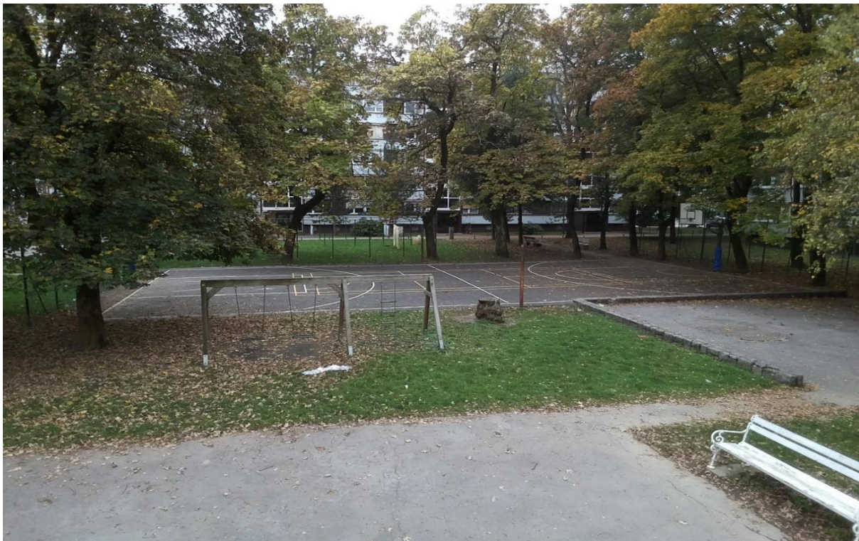
Obnovljeno igrišče v Čopovi ulici, foto: Riko Mlekuž
