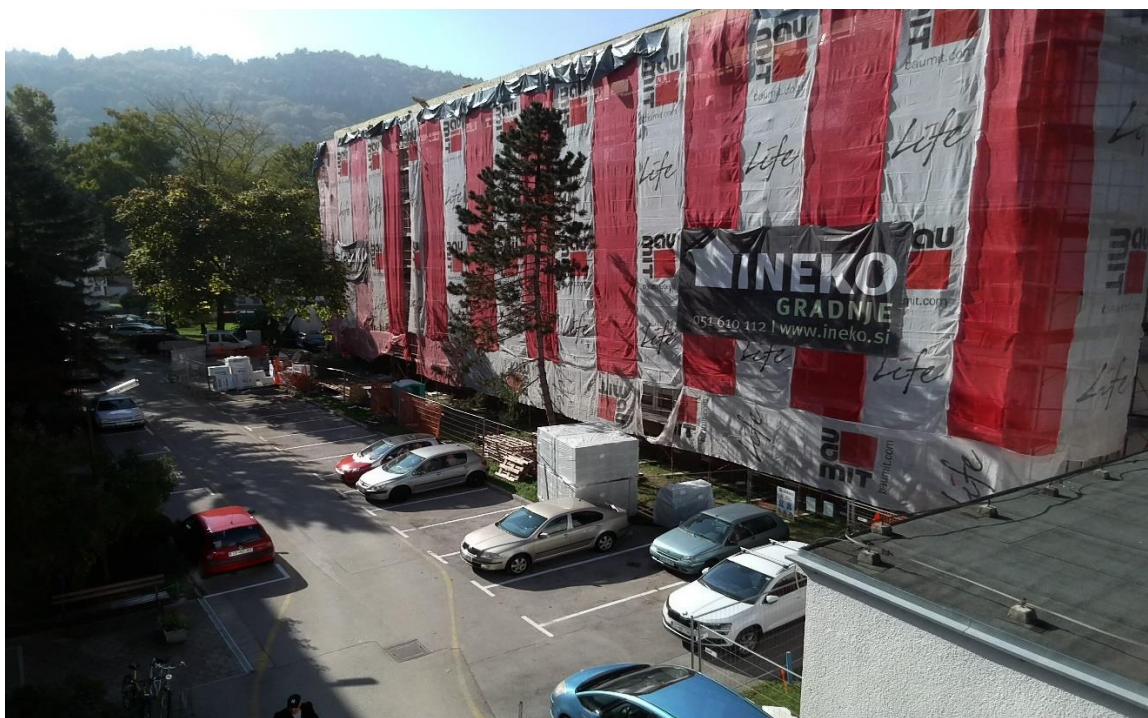
Sanacijska dela na večstanovanjskem objektu Trubarjeva 40,42, 44 (na cestišču vidne tudi nove talne obeležbe parkirnih mest), foto: Riko Mlekuž
