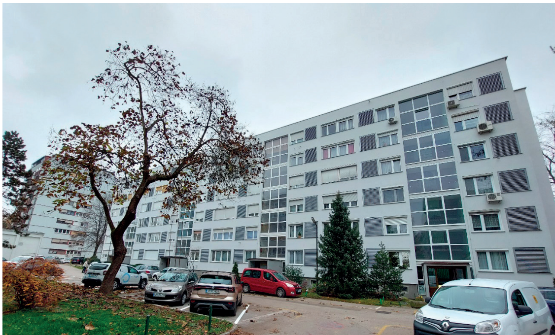
Obnova fasade na Trubarjevi ulici 32 – 34 – 36 – 38. (Foto: Riko Mlekuž)
