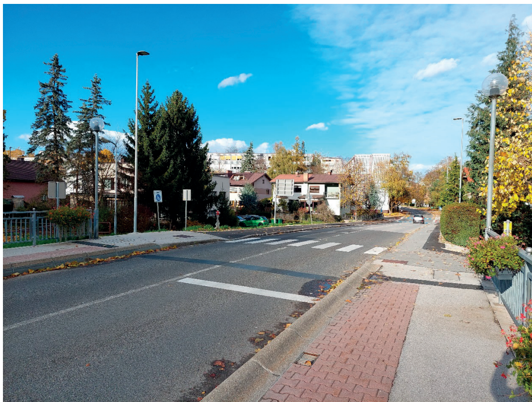
Postavitev dodatne javne svetilke, ki osvetljuje prehod za pešce na levem bregu Savinje, na Čopovem mostu. (Foto: Riko Mlekuž)
