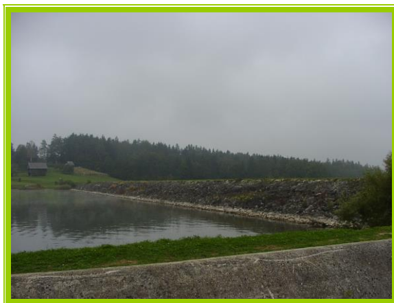
Slika št. 2: Akumulacija Šmartinsko jezero – notranja stran pregrade
