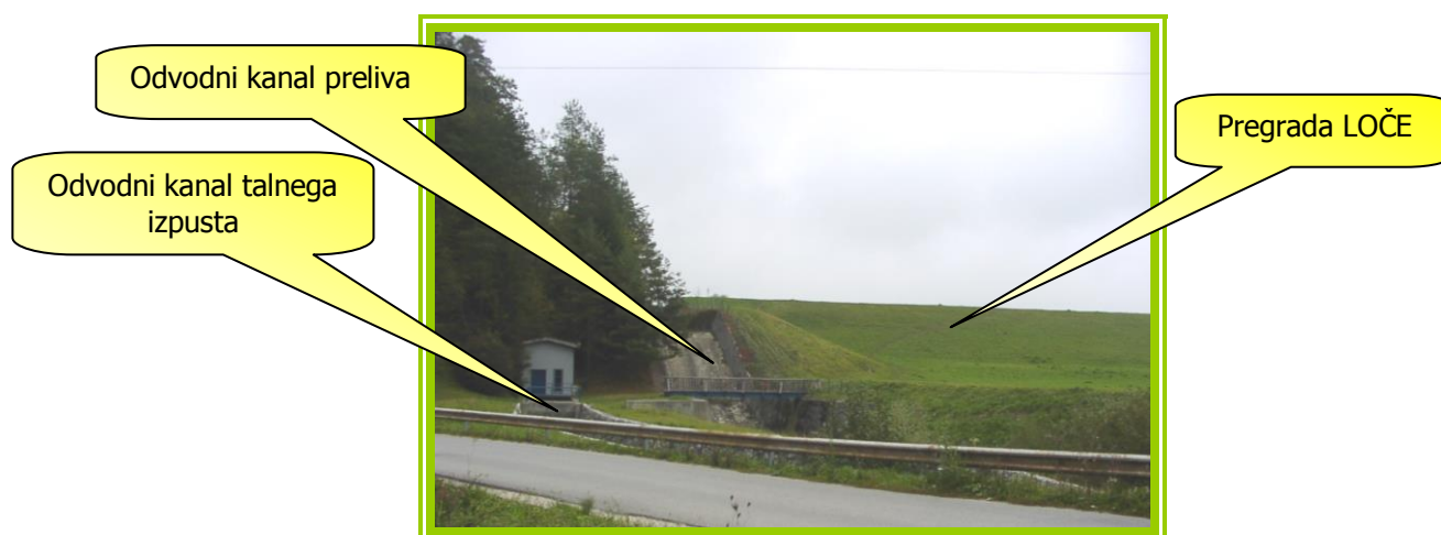
Slika št. 3: Akumulacija Šmartinsko jezero – zunanja stran pregrade
