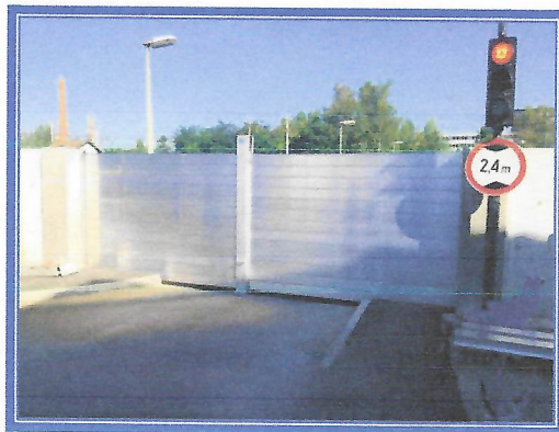
Slika 1: Predstavitveno postavljene protipoplavne zagatnice na mostu čez Voglajno; Kočevarjeva ulica (pri »svinjskem sejmu«), september 2015
