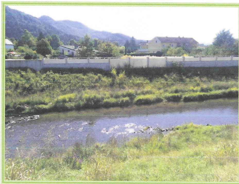
Slika 4: Stalno postavljene zagatnice na Z. Ložnici (območje Špica), 2016
