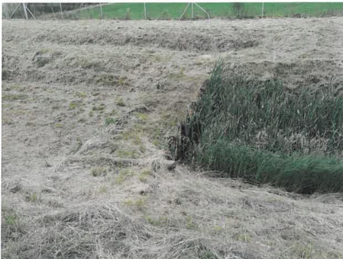
Slika 5: Pogled na del prve RČN, kjer je meja med stoječo vodo z močvirskimi rastlinami in delom, kjer so bile prvotno zasajene trstike (vir: Drev, 15.6.2023)
