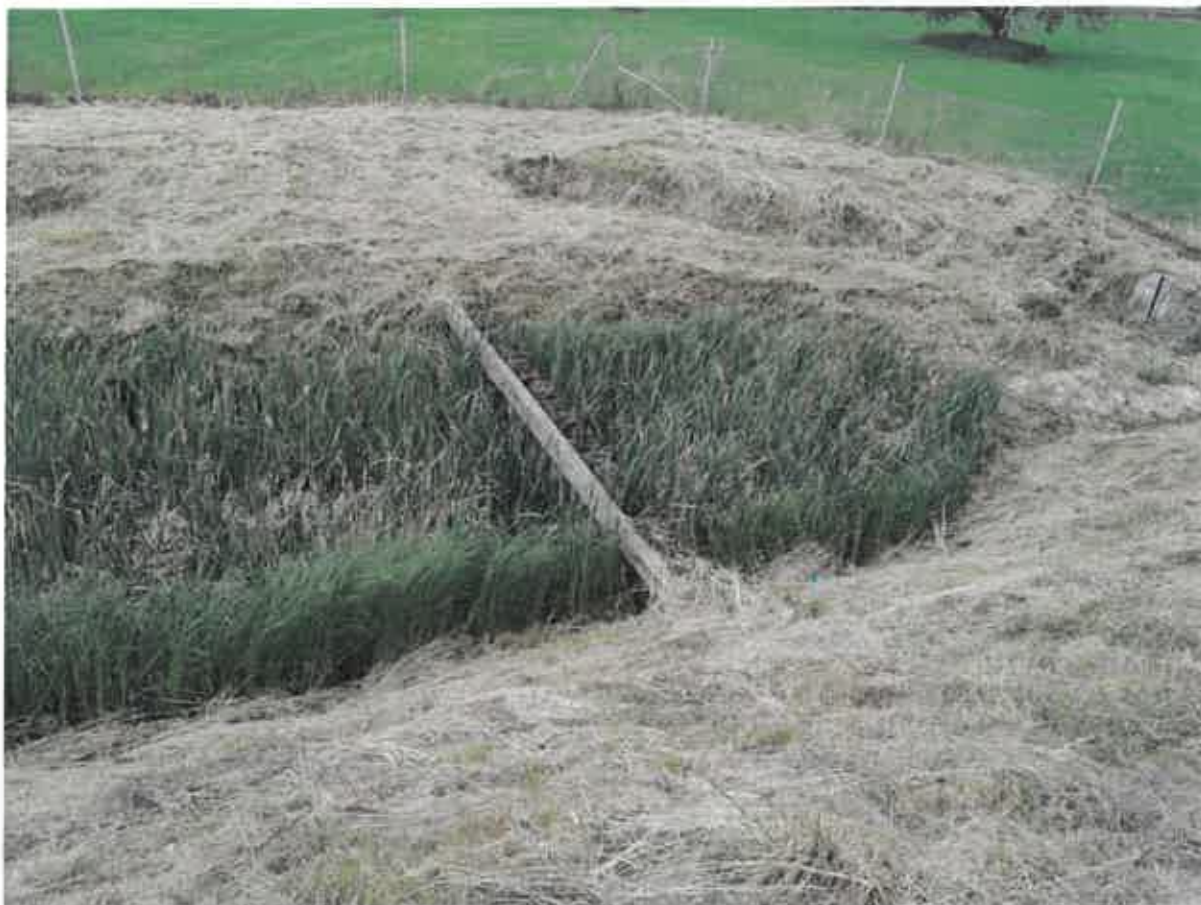
Slika 3: Pogled na začetek prve RČN v katerem je stoječa odpadna voda iz brežine avtoceste (vir: Drev, 15.6.2023)
