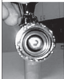
Junta tórica para el grifo
