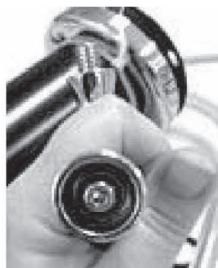
Junta tórica para el grifo
