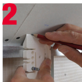
2 Biseau pour tracer/ mesure plaque sous rampants.
