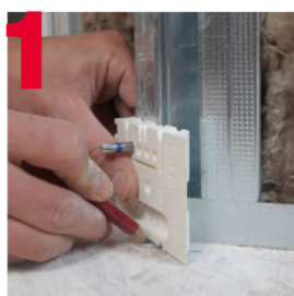
1 Cale ép. 13 mm pour tracés, implantation, huisseries, ...
