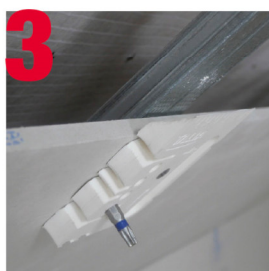
3 Maintien de la plaque en pose rampant
