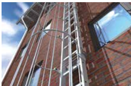
Echelles de secours
