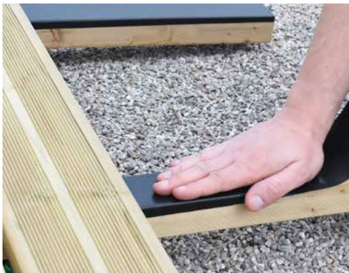
Étanchéité des lambourdes bois sous terrasse
