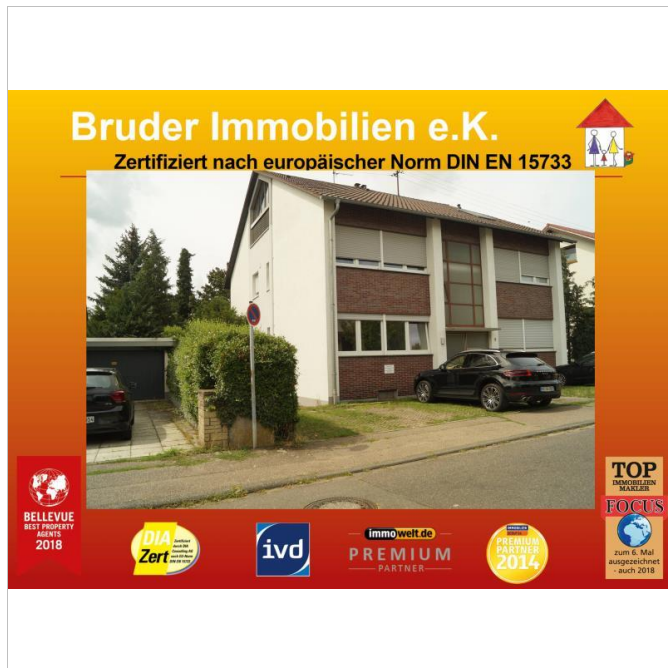
Fassade mit Stellplatz
