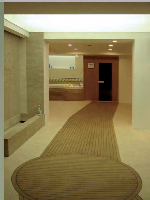
Lichtdecke im Objektbereich
