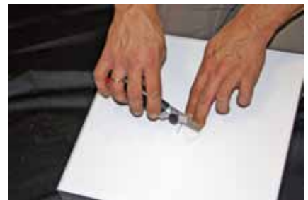
9. Eine Öffnung in die Gewebbahn schneiden
