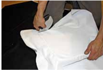
2. Gewebbahn in die Profilleiste drücken
