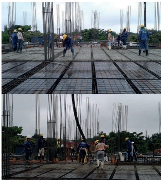
Foto 4: Proceso de fundición de la losa.
