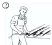
2 Rens røret før bruk. Materialrester og smuss er ofte årsaken til lekkasjer i ventiler.
