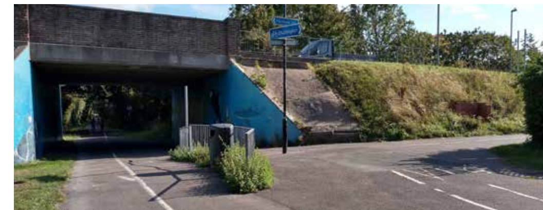
350.5.3.A Henry Court Way beneath B3334
