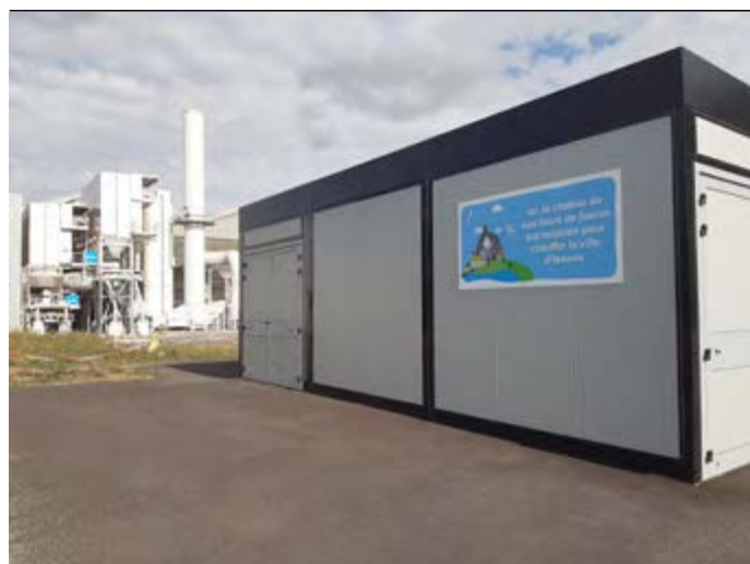
▲ Ce bâtiment contient l'échangeur de chaleur qui permet de chauffer un certain nombre d'habitations de la ville d'Issoire.
