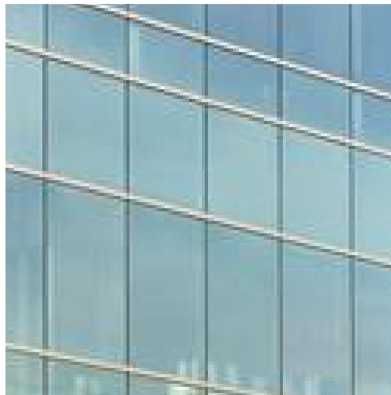
BUTT-JOINT CURTAINWALL:
