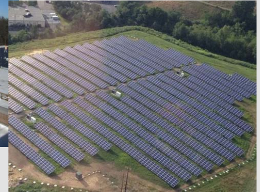
1.5MW, Sudbury Landfill
