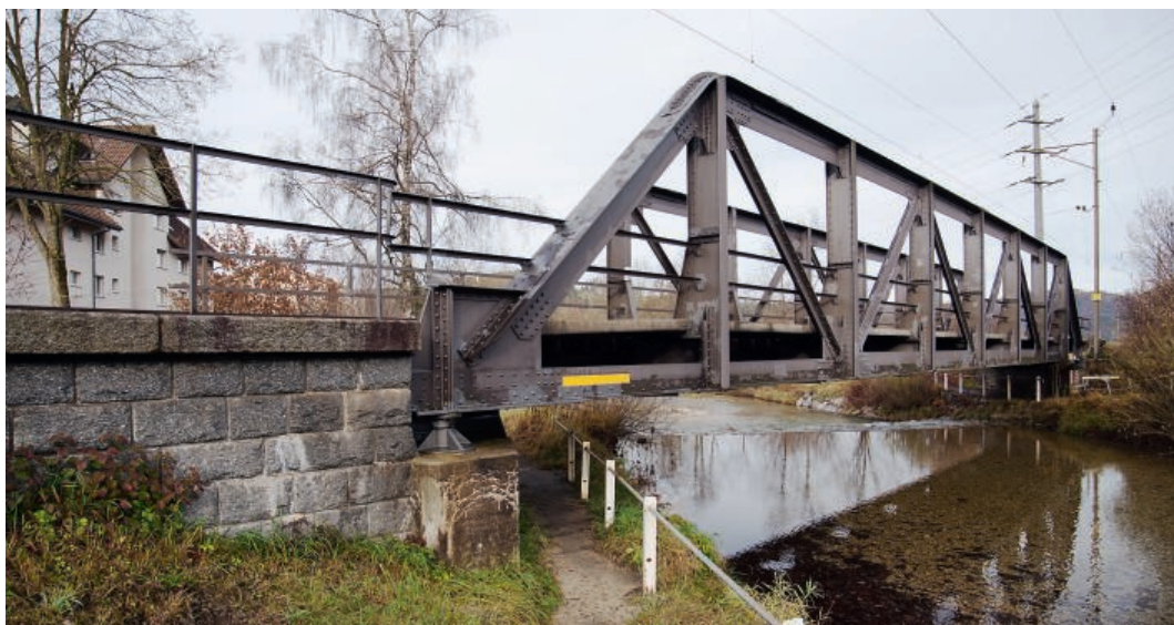
Wila: Stahlfachwerkbrücke der Tösstalbahn. (Foto Cornel Doswald)
