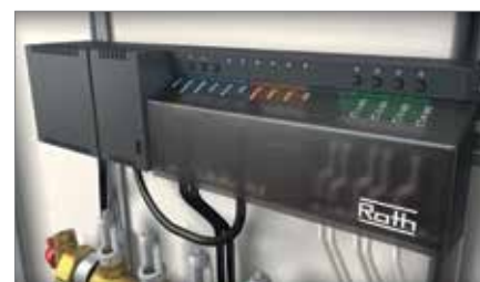
1. Kiinnitä ohjausyksikkö ja kytke toimilaitteet.
