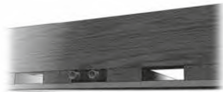
Esimerkki putkien sijoittamisesta katon harvalaudoitukseen.
