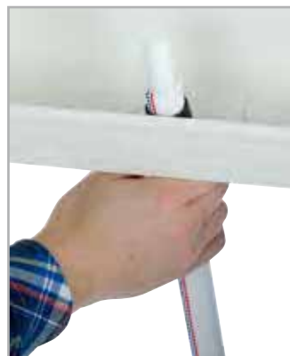
Työnnä suojaputki ja PEX-putki holkin läpi.
