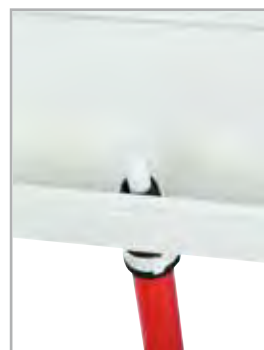
Työnnä PEX-putki kaapin sisälle.
