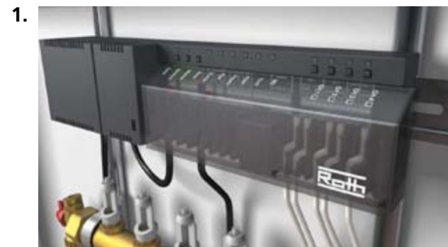
1. Kiinnitä ohjausyksikkö ja kytke termomoottorit.
