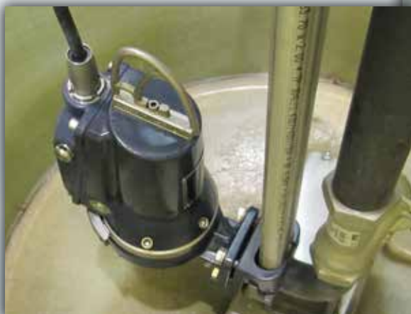
SEG-pumpun pintakytkimet reagoivat vedenpinnan vaihteluun ja ohjaavat pumpun toimintaa tarpeen mukaan.
