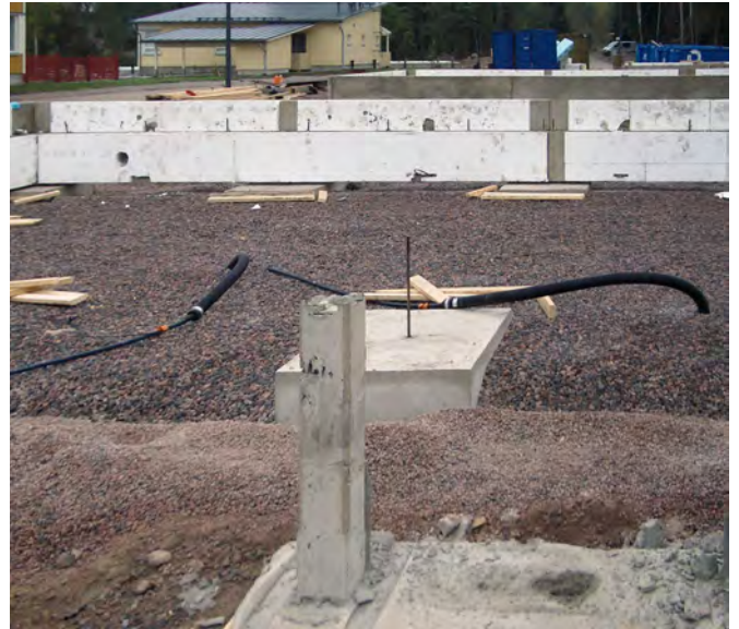
Uponor Mantle toimii tonttijohdon suojaputkena ja varmistaa samalla veden pysymisen sulana.
