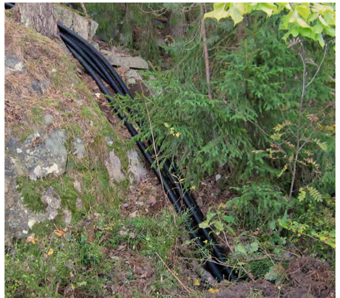
Supra-putket voidaan asentaa tarvittaessa pinta-asennuksena.
