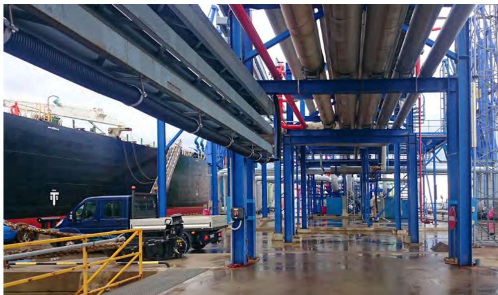
Ilma-asennukset ovat alttiita kovillekin pakkasille
