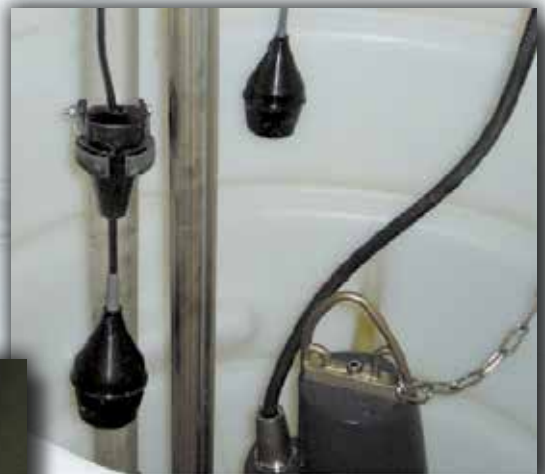
SEG-pumpun pintakytkimet reagoivat vedenpinnan vaihteluun ja ohjaavat pumpun toimintaa tarpeen mukaan.
