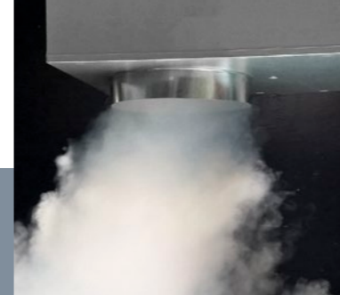
PERINTEINEN TASAUSLAATIKKO Jos laatikon sisällä on turbulenssia, hajotin voi jakaa ilman epätasaisesti.
