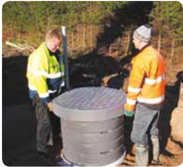
Nosta säätökaulus, tolppaputki ja asennustarvikkeet säiliön sisältä. Käännä säätökaulus ympäri.
