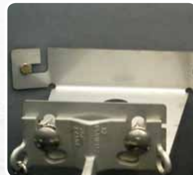
Kiinnitä johdeputkien yläkiinnike säätökauluseseen. Säätökaulusessa on valmiit kierteet.
