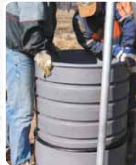
Käännä säätöosa oikein päin ja aseta se pumppaamorungon päälle. Aseta säätökaulus siten, että pumppaamon ja säätökaulusosan sarakat ovat samassa linjassa.
