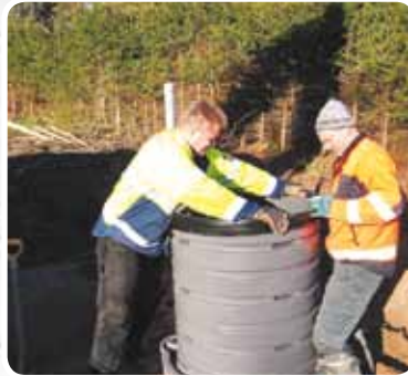
Mittaa oikea korkeus säiliölle ja aseta tiiviste sopivaan säätökaulusuraan, jolloin pumppaamo on oikean mittainen maastoon. (Yleensä alimmainen ura on sopivin.) Asenna kumitiiviste säätöosassa olevaan uraan ja varmista sen paikalleen asettuminen.
