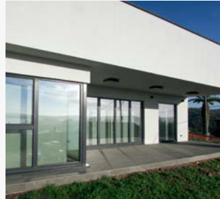
Passiivitalo. Asuinrakennus. Miño, Espanja. Aquarea.
