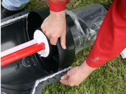
7. FI Asenna puolikkaat t-haararungot toisiinsa kiinni (Varmista, että "TOP SITE" on ylöspäin).
