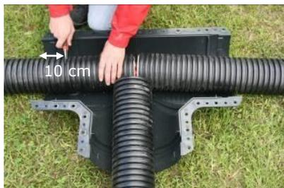
1. FI Aseta putket mahdollisimman "rennosti", pääputki suoraan, oksaputki 90 asteen kulmaan.
