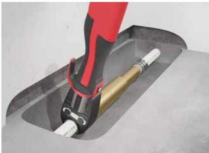
Kuva 30: Korjausliittimien asennusvaiheet.
