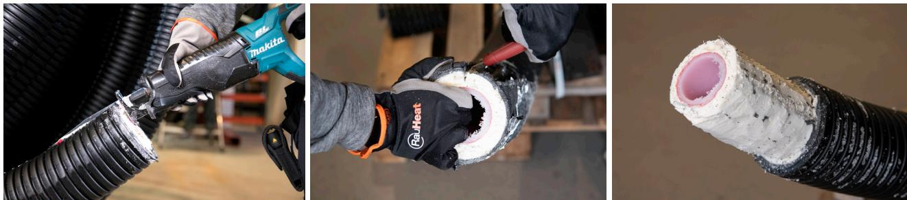
2. Ta bort PUR-isolering från röret genom att dra in skalverktyget mot mediaröret och dra det sedan i mediarörets längdriktning på rörets yta.
