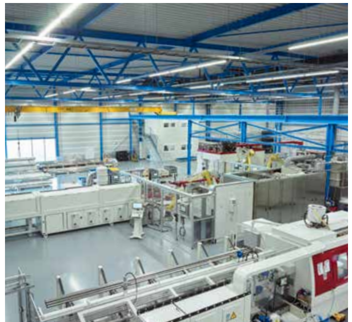
VSH PowerPress -järjestelmän huipputeknologinen tuotantolaitos
