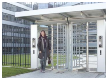
Sécurisation extérieure du site
