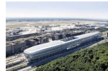
The Sqaire Airport Business Center, Francfort (Allemagne)
