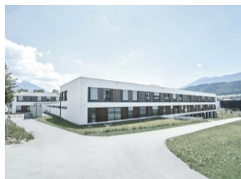
Sécurisation des bâtiments
