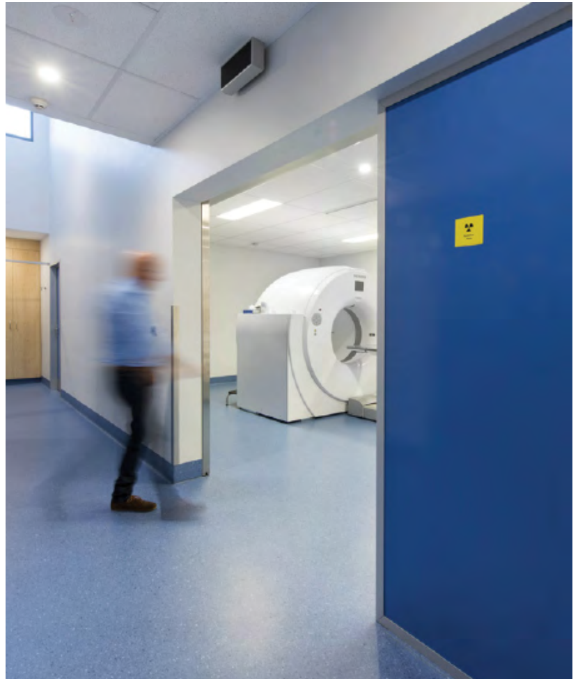
01 Porta rivestita in piombo equipaggiata con ES 400/AL 501
