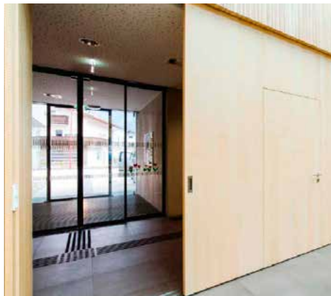
Brandschutzschiebetüre Holz, mit Fluchtfunktion
