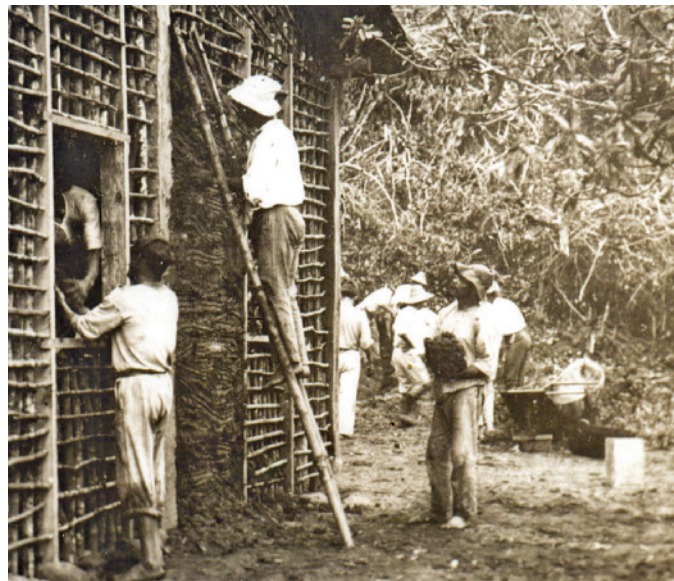
» Casa de pau a pique sendo construída, no século passado, pelo método do mutirão, em São Sebastião, litoral do estado de São Paulo.
