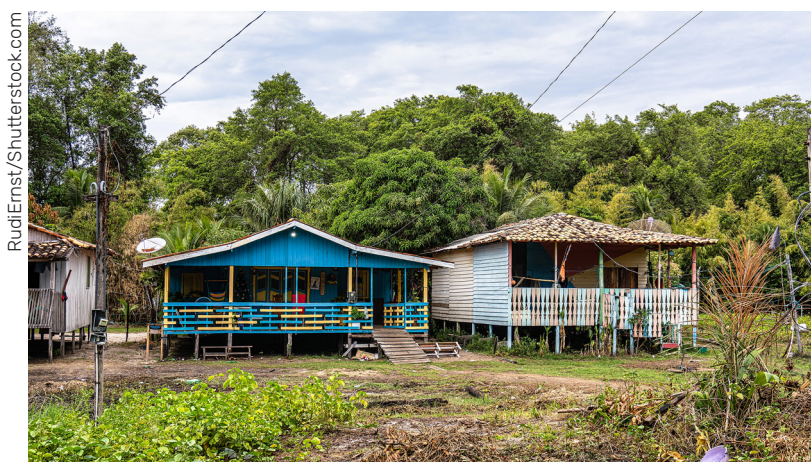
Casas com varandas em Pesqueiro, na Ilha de Marajó (PA), exemplificam habitações em terra firme que utilizam varandas, pé-direito elevado e aberturas amplas como estratégias para favorecer a ventilação natural e reduzir o calor e a umidade.
