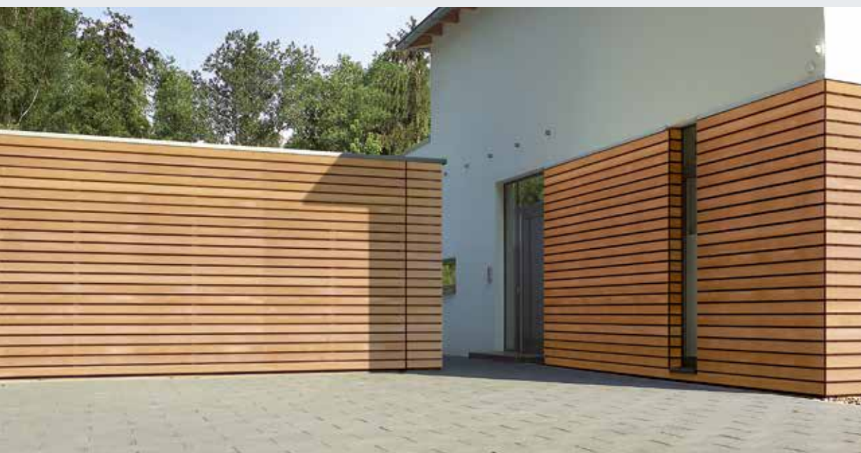
Opláštění dřevěnými panely v místě stavby
