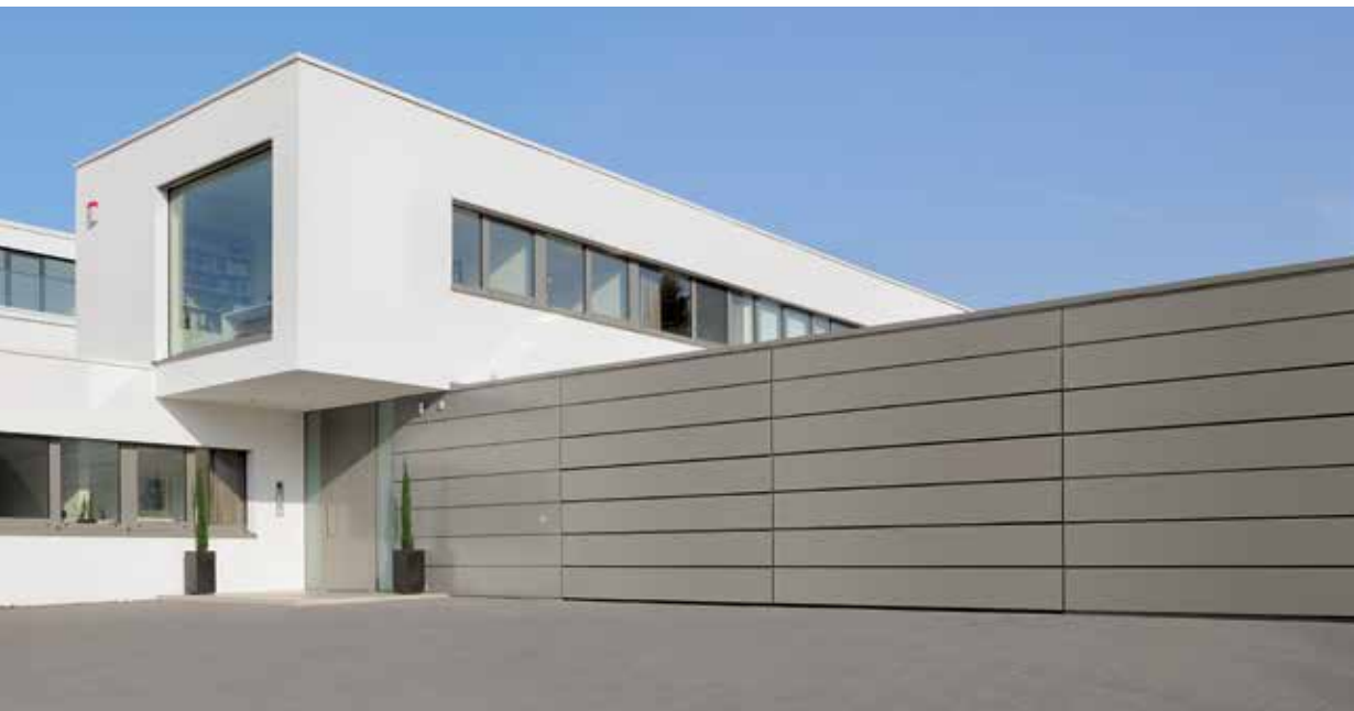
Opláštění hliníkovými sendvičovými deskami v místě stavby
